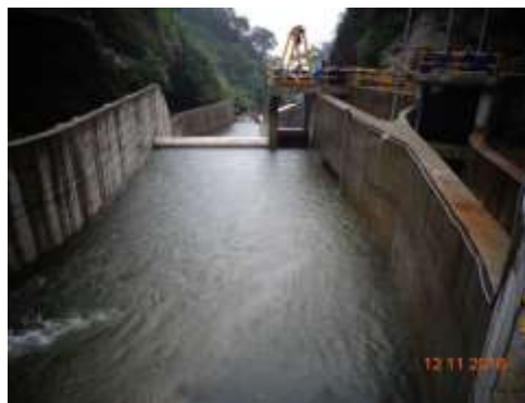
Foto 2. Captación del río Victoria
