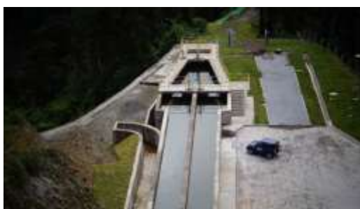
Foto 3. Desarenador tanque de carga en funcionamiento
