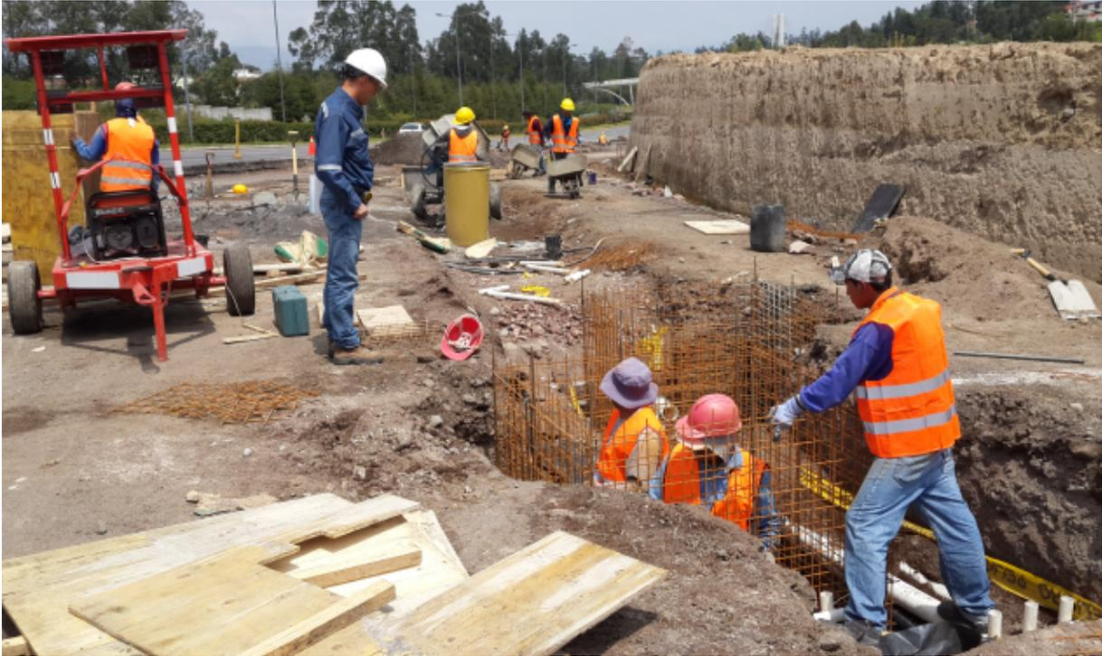
En la vía Interoceánica se realizan las excavaciones necesarias, para instalar posteriormente los sistemas de ductos.
