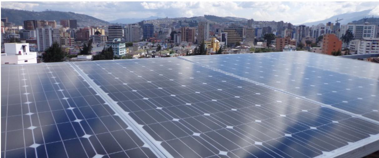
Construido con fines demostrativos, se instaló un sistema solar fotovoltaico conectado a la red que provee de energía eléctrica para el uso en las oficinas de la EEQ en el edificio El Transformador. El sistema está compuesto por nueve paneles solares con una potencia de 2 340 Wp a un costo de USD 11 000.
