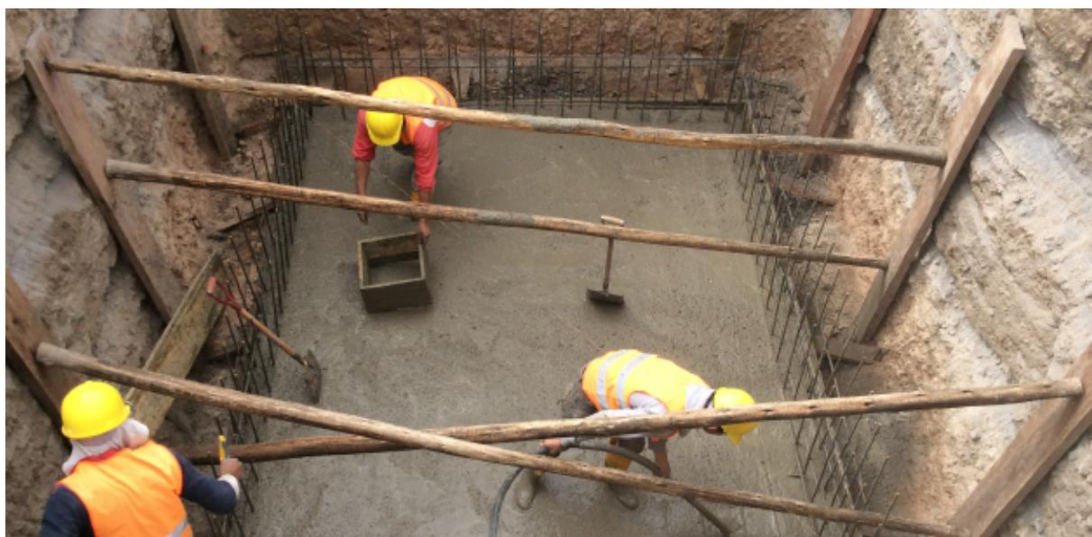
*Fundido de piso Cámara de Transformación
